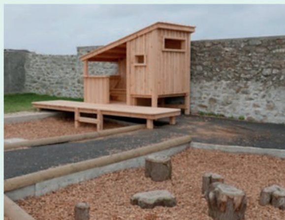
Construction de cabanes dans la cour d'école de Ouessant - (29) - Atelier Bivouac
