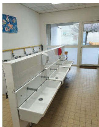
Travaux sanitaires école
