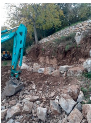
Mur des Bouyons - Avant
